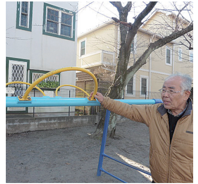
ボルトが緩んでいないか、塗装がはがれていないか、確認します。
